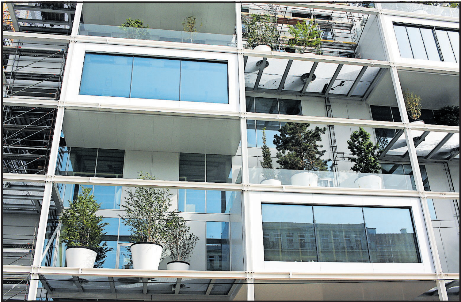
Die Pflanztröge mögen von außen schlicht aussehen, doch es sind hoch technisierte Behältnisse mit Sensoren.
